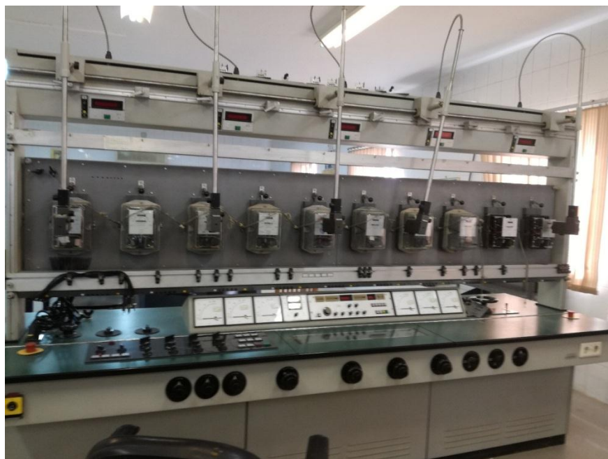
شکل ۳- تابلو تست کنتور ۲
